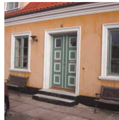
En forbillig udført udskiftning af dør og vinduer i tidlig 1800-tals hus.
