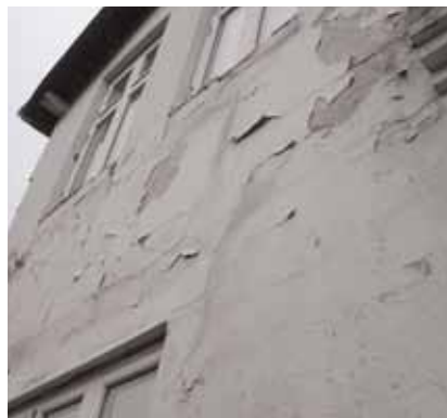
Det bliver desværre ofte til "Laser og pjalter" – det dér med plastikmaling.
